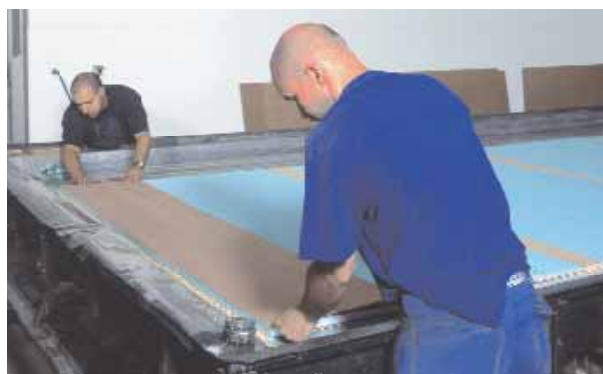
Rys. 08 » Po zastosowaniu kleju, instalowana jest laminowana warstwa drewniana.
