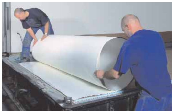
Rys. 09 » Montowanie warstwy okładzinowej (na zdjęciu - GRP)
