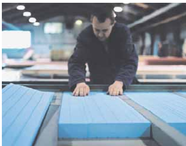
Rys. 13 » Montaż płyt STYROFOAM w panelu podłogowym.
